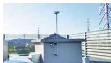
ロードヒーティング 積雪検知器
