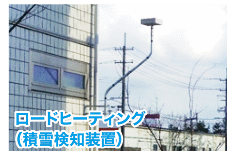
ロードヒーティング積雪検知器
