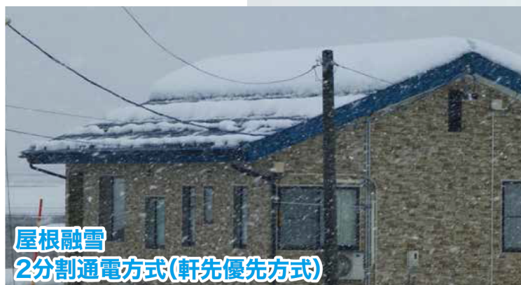
雪害による屋根崩落対策
