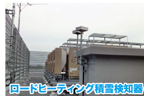
ロードヒーティング (積雪検知装置)
