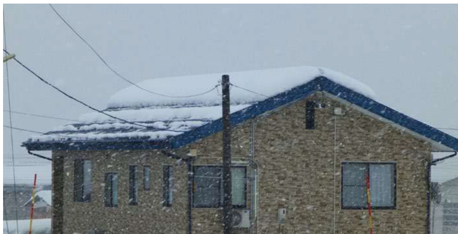
屋根融雪：2分割通電方式（軒先優先方式）
